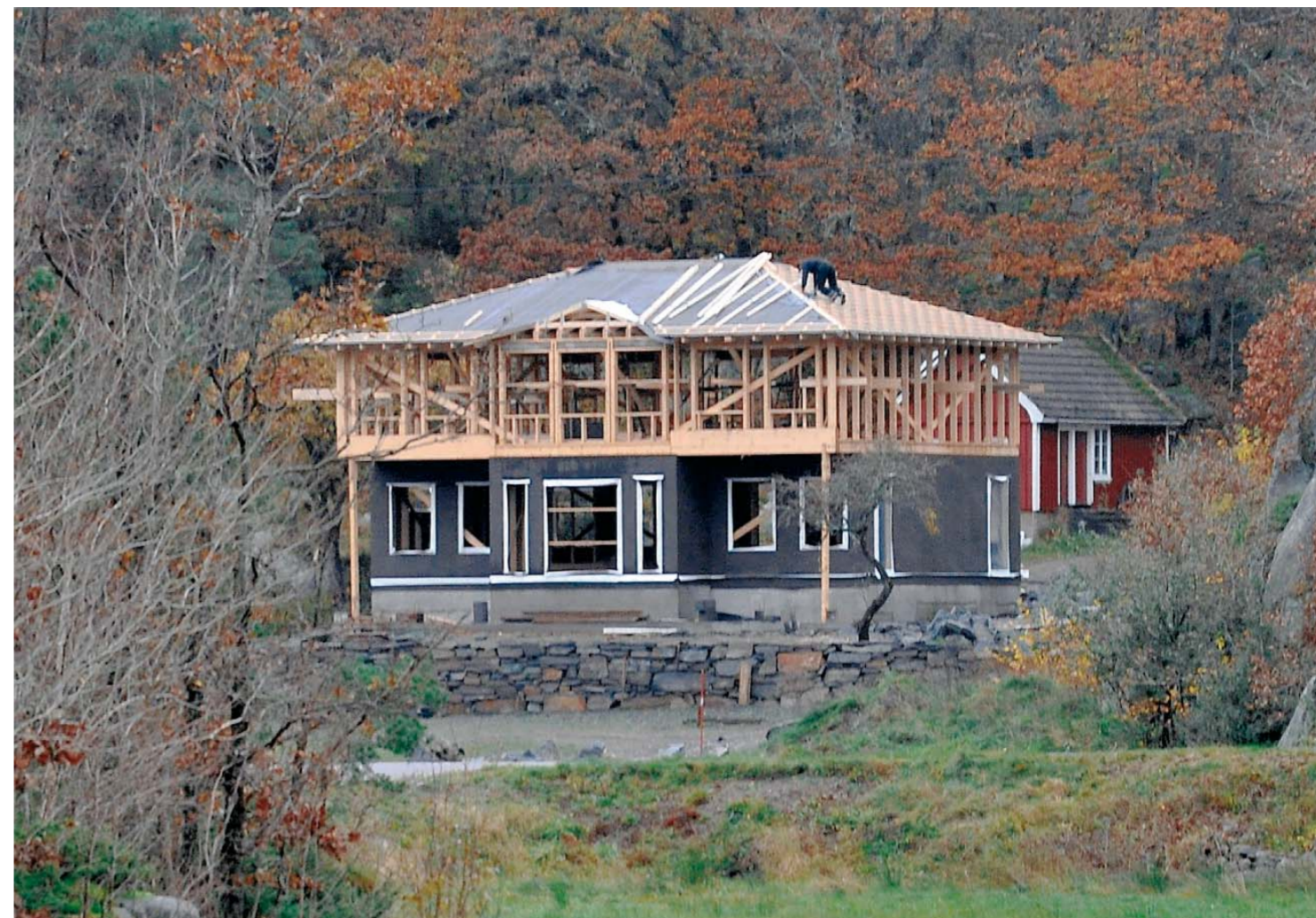
IKKE SØKT: Tiltakshaver har uten å søke revet den gamle bygningen og ført opp ny bolig. Nå må fullstendige søknader på alle tiltak sendes kommunen.
