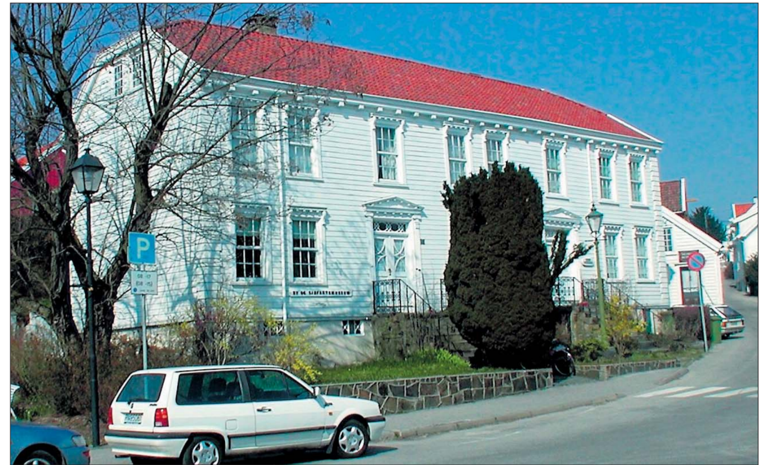
OPPVEKST: I slutten av 1820-årene etablerte faren til Hans Jacob Grøgaard seg som handelsmann i Nygårdsgaten og bygget det hus som i dag er Lillesand By- og Sjøfartsmuseum, hvor «Minutten» vokste opp.
