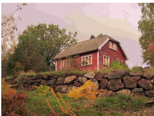
Fosselia 14: Huset så ut til å være i dårlig stand, men var i overraskende god tilstand.
