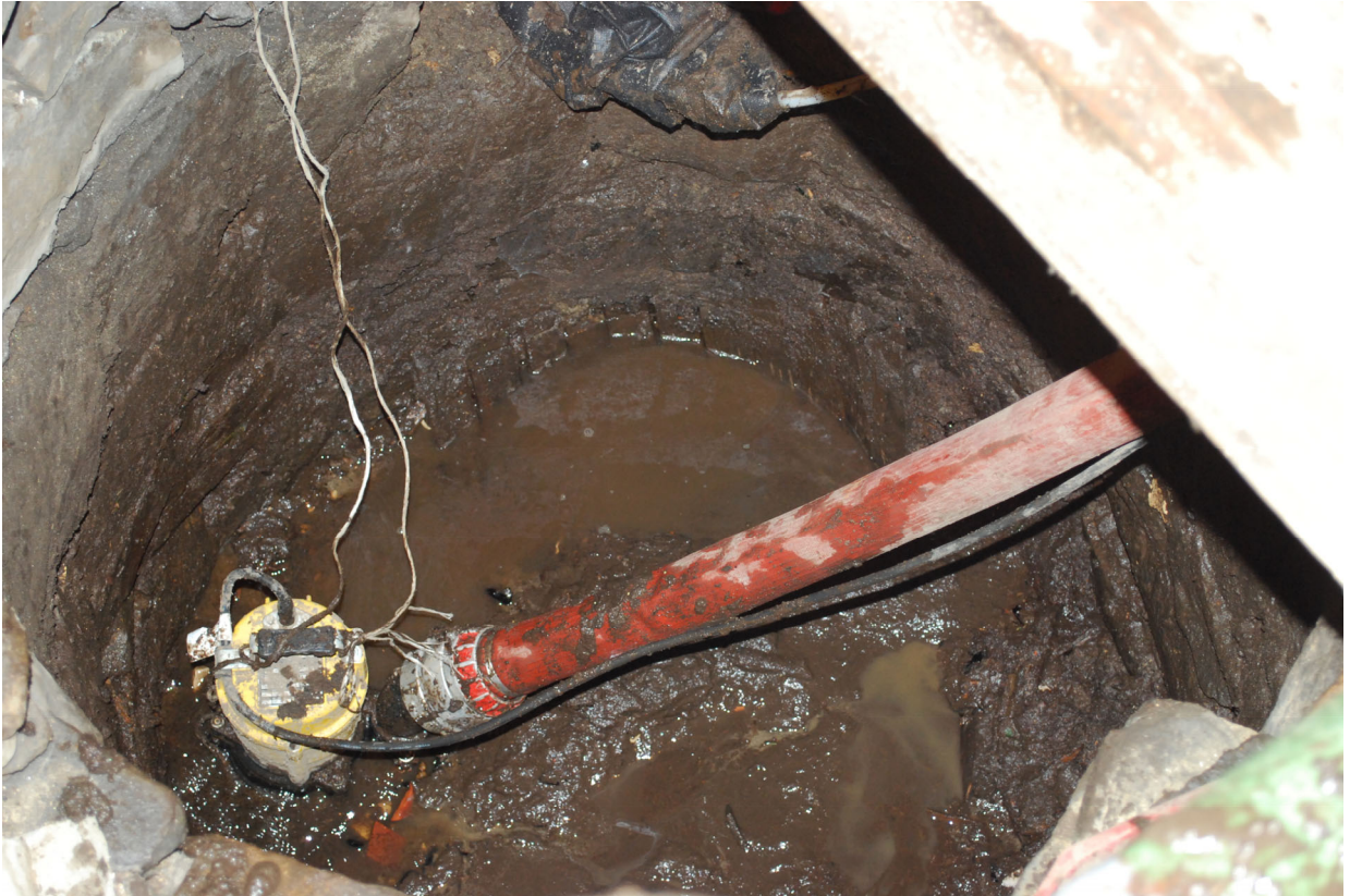
Figur 19 Pumpen går hele tiden for å unngå at det skal smale seg opp for mye vann. Toppen av tønnebordene kan ses øverst i bildet og stikker like opp av det gjørmete vannet.
