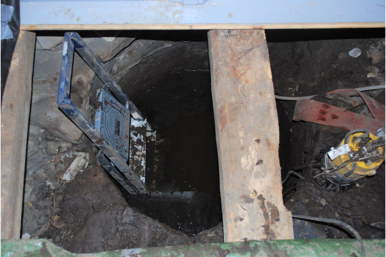
Figur 20 Vannivået på morgenen før man startet pumpingen av brønnen før gravingen. Stigen var høyst nødvendig for å kunne komme seg opp og ned.
