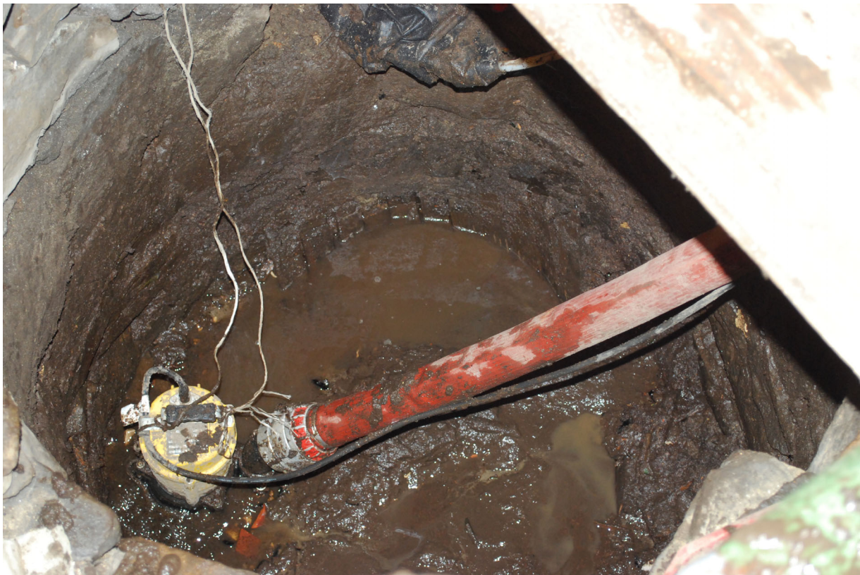
Figur 8 Situasjonsbilde – under graving av brønnen. Her i lag 3 med pumpen gående for fullt. Rester av tønne kan ses midt i bildet, like over vannflaten.
