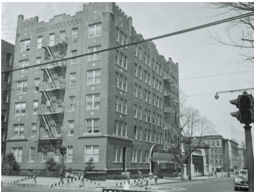
Alvilde Magdalene og John bodde på en rekke adresser i New York. Blant annet i denne bygningen i Bergen Street. FOTO: LINDA RAOGK
