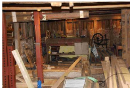
Seilloftet under laftearbeidet
